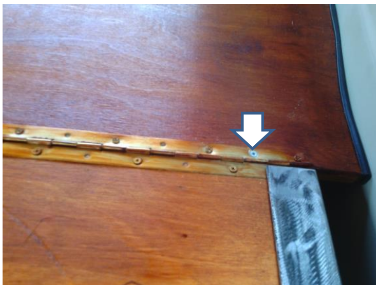
Рисунок 12 Место крепления фигурной части винтом М3 к уголку 40 мм.
